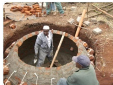
Bau von Biogasanlagen für Haushalte in Kenia
